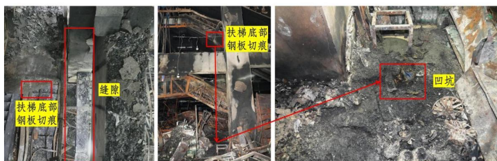
图 14 扶梯底部钢板切痕、横梁与扶梯的间隙和衣物位置示意图
