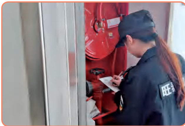
▲ 消防设备日常巡检
