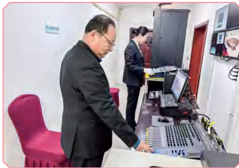
▲ 机房设备调试
