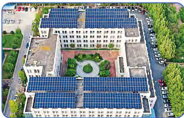
▲ 聊城市东昌府区机关办公楼合同能源管理项目
