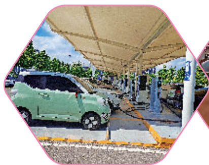
新能源充电站
