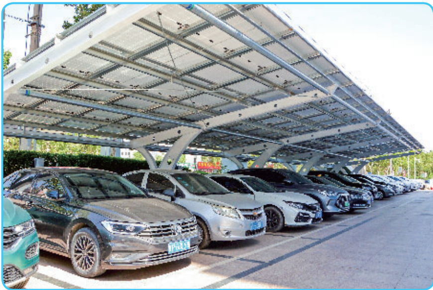
▲ 市直机关办公区太阳能光伏车棚项目
